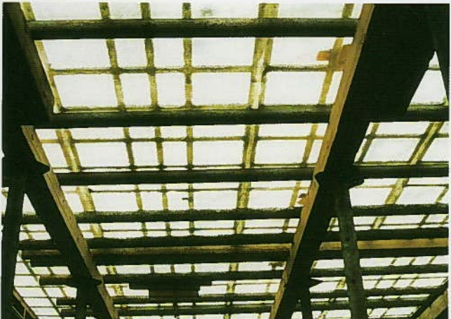
スラブの施工
