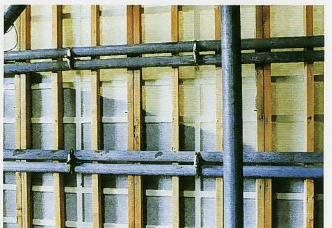
コンクリートの流動状態
