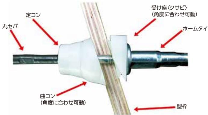
◎ 曲コンと受座が自由に動くので、締め付けるだけで角度が設定できます。
