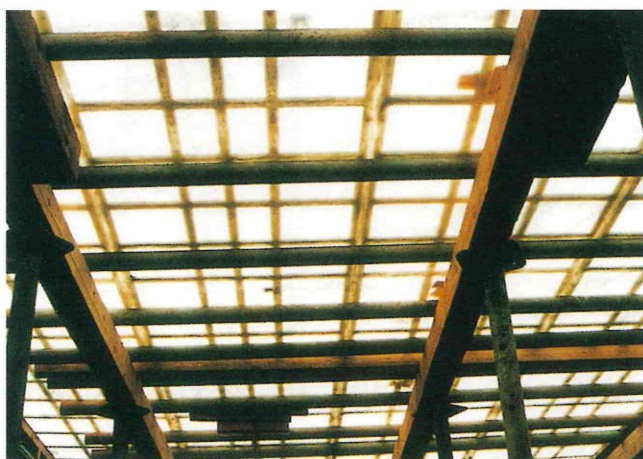
スラブの施工
