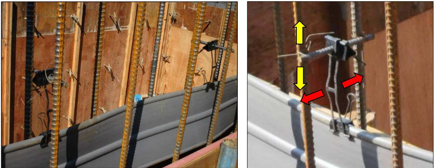
◆ 止水板を取り付けた後、止水板が壁の中心になる様に捨て筋側のクリップを左右に移動させて位置を調整して下さい。又、高さ(レベル)の調整は捨て筋の取り付け位置を上下させて調整して下さい。
