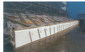
モイスマット®で湿潤養生中
