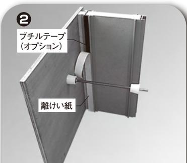
スリット本体を目地棒に差し込む形で取り付ける。
