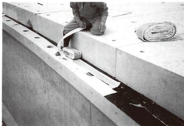
▲プレキャストコンクリートの止水材として
