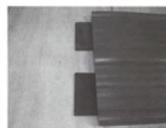
\* 止水板に巻癖があるときは、なるべく巻癖を修正して下さい。又巻癖が上向きになるように置いて溶着作業を行ってください。
