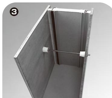
もう一方の型枠にも目地棒を取り付けてスリットを型枠で挟み込み固定する。
