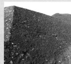
盛土 人為的に盛り付けて造成された斜面
