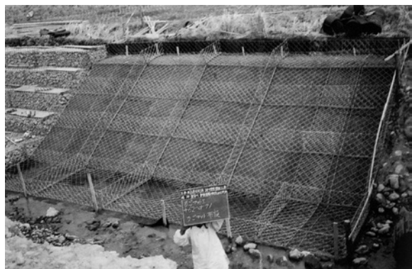
②護岸工かごマット 布設
