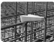
主筋が横の場合取付例
