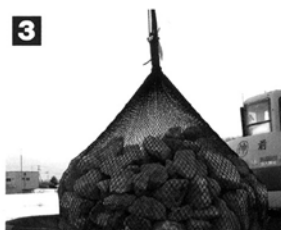
3 型枠からE-ユニットをクレーン等で吊り上げます。
