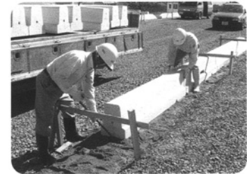
4 位置を合わせ保持し逆サイドから圧着して作業終了
