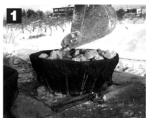
1 製作用型枠内にE-ユニットを設置し、中詰め材を投入します。
