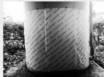
垂直面への施工現場写真
