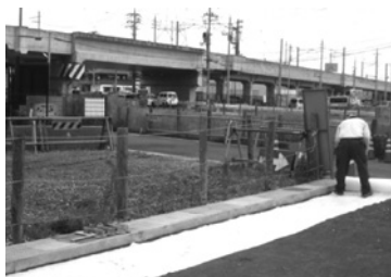
透水性インターロッキングに使用
