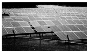
太陽光発電施設の防草対策
