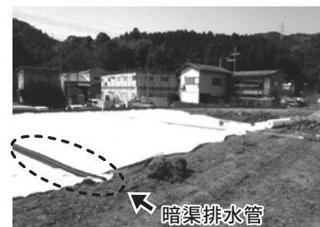
有孔管の目詰まり防止に使用
