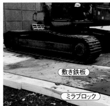
工事振動対策例
