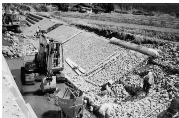
③護岸工かごマット 詰石状況
