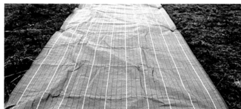
法面、路肩の長期間の防草対策
